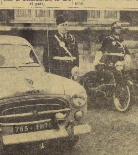
los automovilistas y un "teletalimetro" que registra la velocidad de los vehículos. Este es uno de los radio-patrullas, equipado con todo el material de las cámaras de las motocicletas, el aparato electrónico está montado en el techo y el contador kilométrico en la parte delantera izquierda. (Foto AFP).
