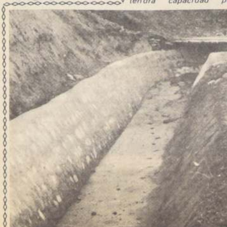
En noviembre próximo será terminada la primera etapa del Canal Cayucupil que la Dirección de Riego construye en el Departamento de Cautín, para regar 800 hectáreas de tierra. El canal tendrá capacidad para
