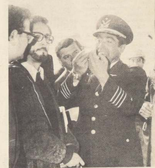
Subsecretario de Obras Públicas, Coronel Guillermo Navarro, explica a los periodistas los sistemas de ventilación provisionarios que se han instalado en el Túnel Lo Prado, en espera de los definitivos que se están colocando.
