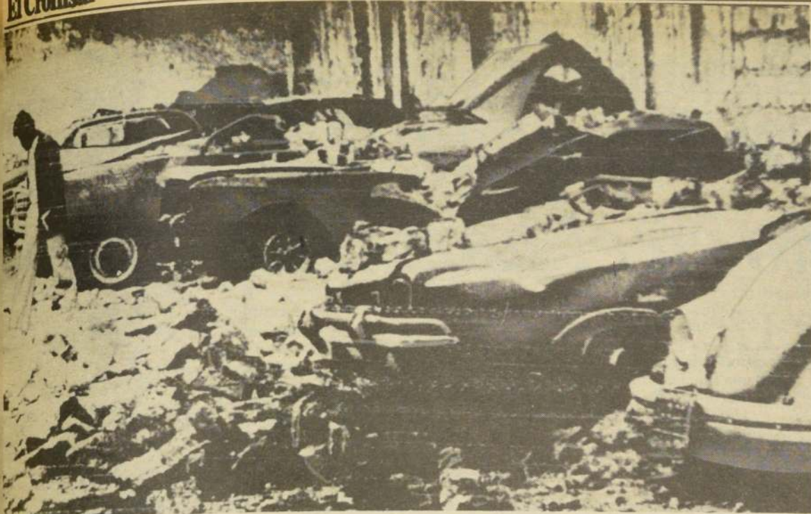
EFFECTOS DEL SISMO. — Así quedaron estos automóviles estacionados en una calle de Ciudad de México al derrumbarse el edificio contiguo. La misma escena se repitió en otras zonas de la capital y la mayoría de las ciudades del país a consecuencia del terremoto que afectó a casi todo el territorio. (RADIOFOTO AP).
