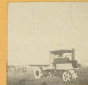
Camión-tractor a vapor que prestó servicios desde 1895 a 1920 en el transporte de lana de antiguas estancias. Su velocidad promedio era de 3 kilómetros por hora.
