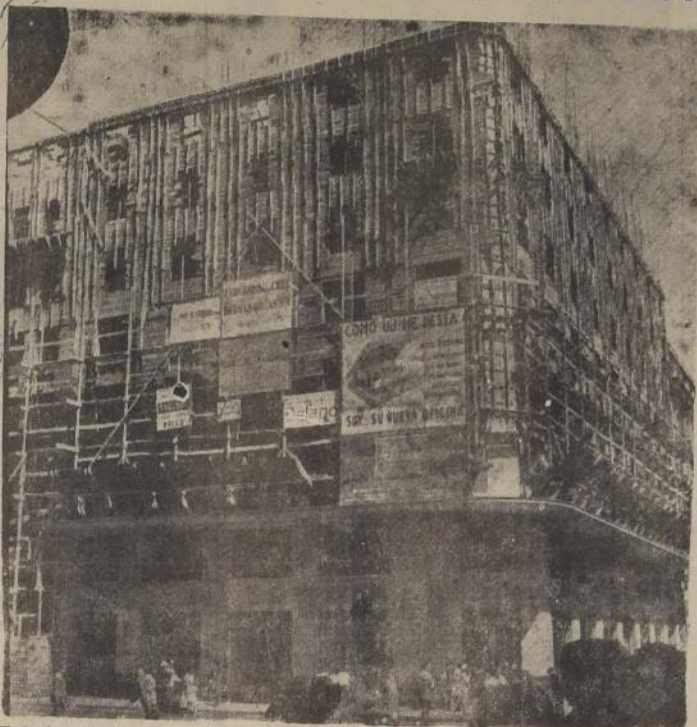
Todavía cubierto en sus pisos superiores por la madera que sirvió para la obra de cemento, aparece el nuevo y moderno edificio que "Socore" ha erigido en Bandera con Moneda, para locales comerciales en el primero y oficinas de profesionales hasta el 10º piso. El primer piso y el entresuelo están ya casi totalmente terminados. El resto de la obra se entregará a breve plazo.
