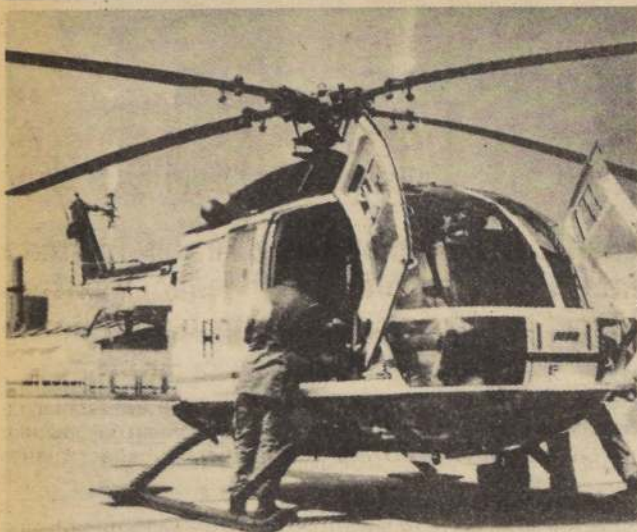
Este helicóptero armado en Chile por ENAER será exhibido por primera vez en la FIDA '86. Está diseñado para tareas de apoyo terrestre, puede transportar dos pilotos y tres pasajeros. Su autonomía de vuelo es de dos horas 40 minutos y puede alcanzar una velocidad crucero de 120 nudos.
