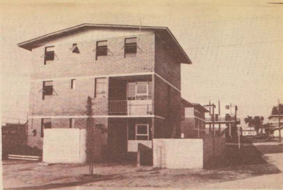
Estos departamentos son muy originales. Innovan en su concepción estructural. Cada piso es una casa y cada casa tiene "su" patio. En la fotografía se puede observar la escalera de la segunda casa que da a su patio, y al otro lado se ve el final de la otra que pertenece al tercer piso y que también da a su patio, y finalmente se aprecia el patio del frente que corresponde al primer piso.
