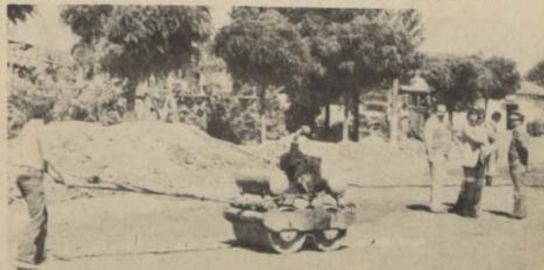
TENO.— El próximo mes deberán quedar terminadas las obras de pavimentación de la calle Sotomayor, tramo financiado por la Municipalidad para facilitar el paso de la locomoción colectiva.
