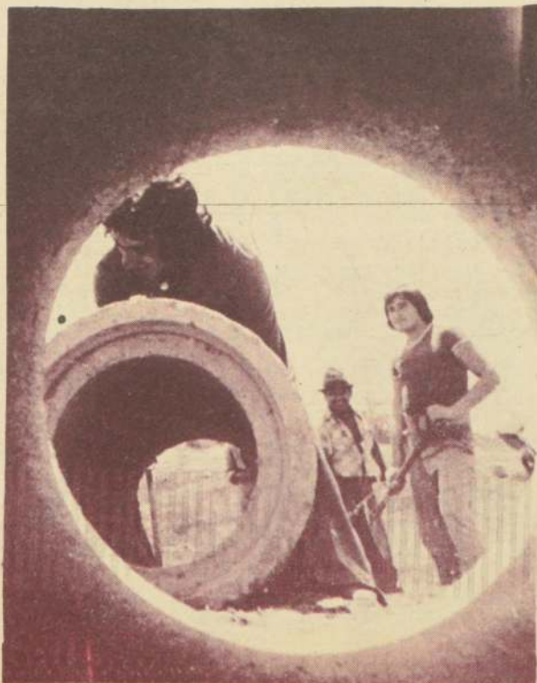
Estos tubos servirán para abovedar el alcantarillado
