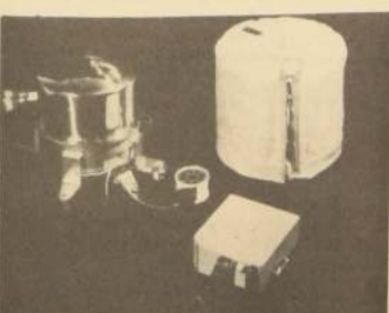
En el grabado (arriba) se pueden apreciar los sensores, la cubierta térmica y los dispositivos electrónicos del Experimento Sísmico Pasivo.
