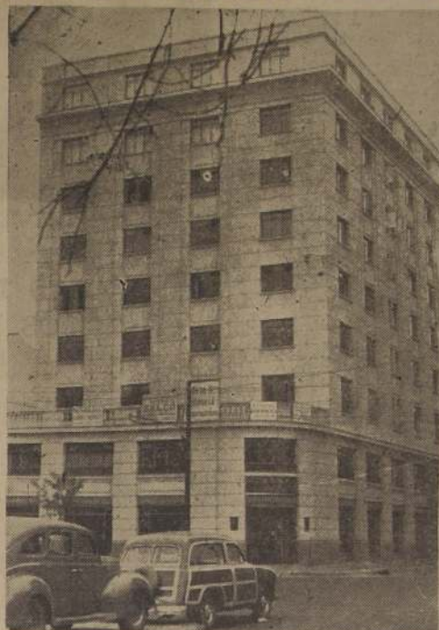
Esta es la construcción que viene a embellecer la esquina de Av. Bernardo O'Higgins con Serrano.
