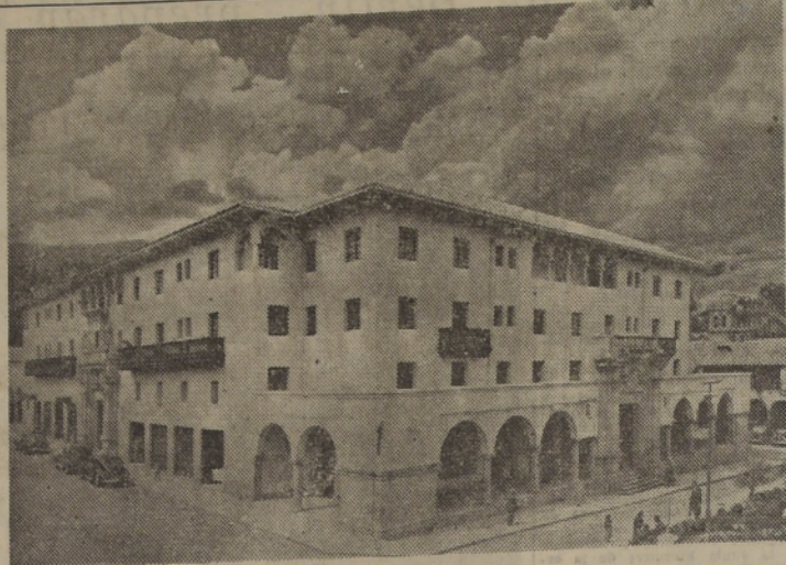
Edificio del Hotel de los Turistas, de Cuzco, el único que no resultó con daños serios a consecuencias del terremoto de ayer que costó más de cincuenta vidas y 250 heridos.— Las verdaderas proporciones de la catástrofe aún se ignoran
