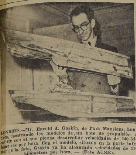
LONDRES.—Mr. Harold A. Gaskin, de Park Mansions, Londres, mostrando los modelos de un bote de propulsión a cohete con el que piensa desarrollar velocidades de 240 kilómetros por hora. Con el modelo, situado en la parte inferior de la foto, Gaskin ya ha alcanzado velocidades de 110 kilómetros por hora. — (Foto ACME).
