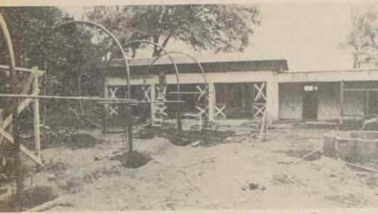
BIBLIOTECA MUNICIPAL. — Para el aniversario de La Cisterna se efectuaron los "tijerales" y ahora se trabaja aceleradamente para inaugurarla el 11 de septiembre.
