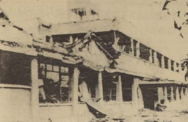
Hanoi. Foto entregada por fuentes oficiales, ayer, en que aparece el edificio del aeropuerto civil de esta ciudad, destruido por causa de las bombas lanzadas en su ataque contra Vietnam del Norte por aviones bombarderos norteamericanos.
