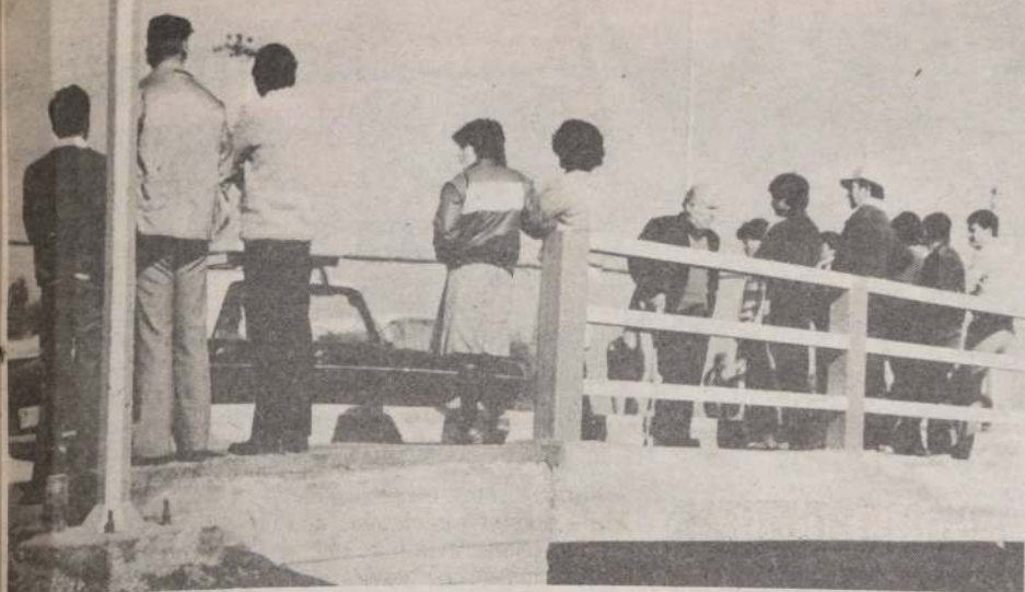
Hay entrada en servicio el puente Departamental sobre el canal San Carlos, luego de ser inaugurado por el Ministro de Vivienda, Miguel Angel Poduje.
