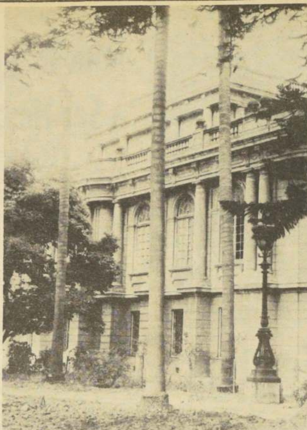
EL PALACIO RIOJA, antes de la restauración. Hoy está todo renovado, tanto en su interior como en los jardines exteriores, que muchos recuerdan como la "Quinta Rioja".
