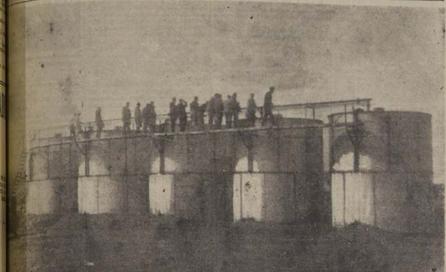
Estos estanques almacenaron los primeros cuatrocientos mil litros de petróleo chileno. Desde ellos parten las tuberías de 72 kilómetros de extensión, que a través de la pampa fueguina, conducen el "oro negro" de Magallanes desde Manantiales hasta Puerto Clarence, en la costa, para ser embarcado. El oleoducto inaugurado hoy por personas del Gobierno, de la Corporación de Fomento y la delegación uruguaya de la Administración de Combustibles, Alcoholes y Portland, enviada a nuestro país para finalizar el primer contrato de compra del valioso elemento.
