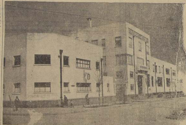
Edificio de la Central de Leche
