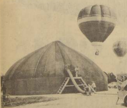
El globo de la fotografía, sobre la tierra, fabricado en Inglaterra, puede almacenar hasta 1.000 toneladas de grano. Hechos con caucho Butyl, a prueba de putrefacción, importan alrededor de tres mil libras esterlinas cada uno y los vende "Cherwell Valley Silos", de Banbury, Oxfordshire, Inglaterra (Foto Jackson, Gloucester).
