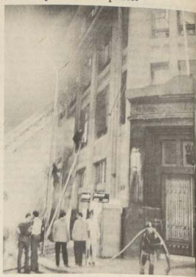
La fotografía muestra el instante del incendio, pocos minutos después de las 21.00 horas del miércoles 2 de marzo, y que afectó a diferentes juzgados ubicados en el edificio de calle Compañía N° 1213.
