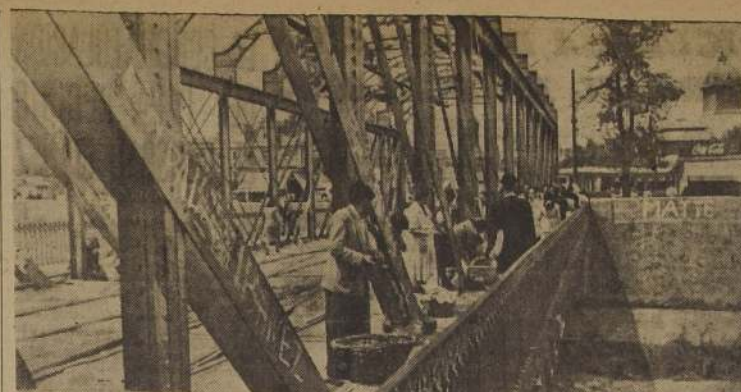
PUENTE CONVERTIDO EN MERCADO. — El viejo "Puente de Los Carros", ubicado sobre el río Mapocho frente a la calle 21 de Mayo, ya no sólo sirve para el objeto para el cual fué construido, sino que también se ha convertido en un pintoresco mercado. En efecto, la parte destinada a los peatones es aprovechada por una veintena de comerciantes ambulantes que expenden paltas, aplo, penca y queso de cabra. En el grabado vemos un aspecto de este pintoresco mercado que, en cierta forma, recuerda a los que se establecen en las riberas del Sena en el milenario París.
