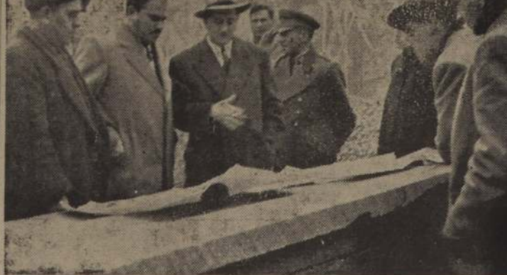
EN EL FUTURO ESTADIO DE PUENTE ALTO. — En Puente Alto se construye un moderno estadio, el que llenará un vacío en ese importante pueblo. Las autoridades locales han tenido especial preocupación en lograr un financiamiento que permita llevar a feliz término esa obra. En el grabado vemos al Ministro de Obras Públicas, señor Orlando Letelier, examinando los planos que le son exhibidos, durante la visita que practica el sábado a dicha obra. Lo acompañan, el Alcalde, don Jorge Valdivia, autoridades locales y los constructores.
