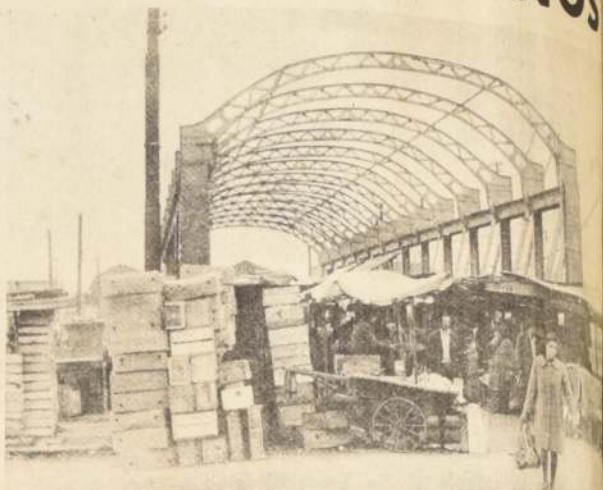
Una total transformación experimentará la ribera sur del Río Mapocho con la construcción de modernos kioscos metálicos para todos los vendedores ubicados en ese lugar en forma provisional. Los que fueron erradicados del centro de la zona.
