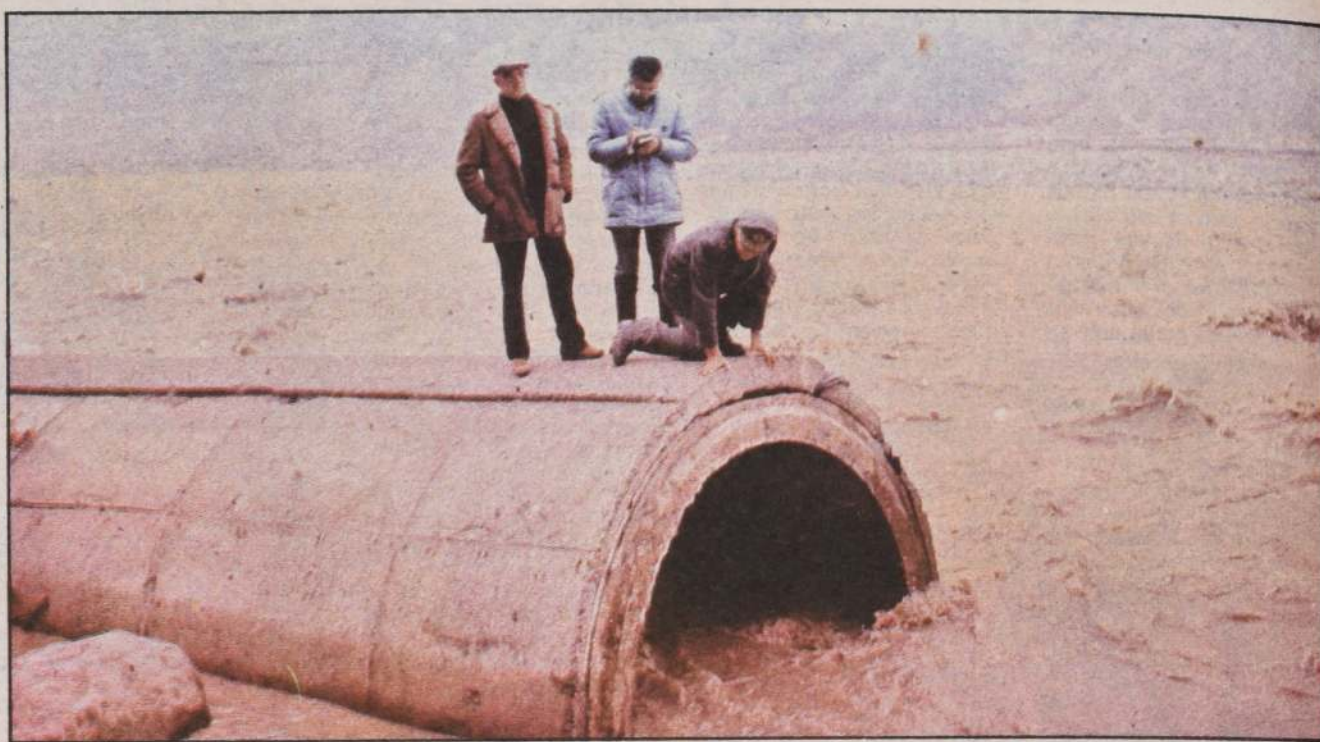
El Ministro de Obras Públicas, general Bruno Siebert, inspecciona las tuberías que destruyó el desborde del río Maipo. Ellas serán reemplazadas con cañerías de acero, que permitirán llevar agua a la planta Las Vizcachitas.
