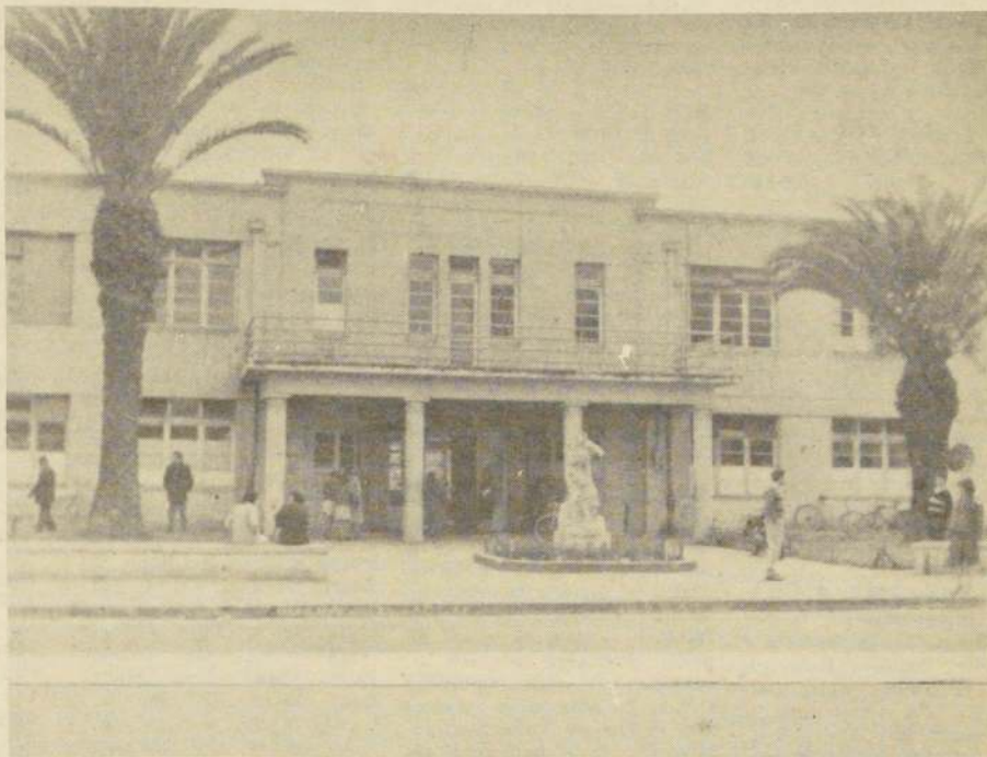
FRONTIS del antiguo Hospital Regional de Talca, el que ha estado a punto de ser cerrado y demolido en varias oportunidades por su obsolescencia.
