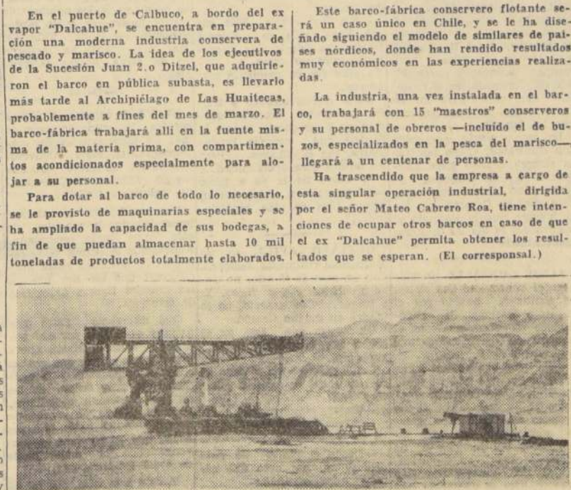
LA GRUA TITAN PARA FABRICAR BARCOS. — En este lugar del puerto de Iquique se instalarán los asideros que producirán hasta dos embarcaciones mensuales. La grúa titan, que aparece en el grabado, servirá para sujetar el casco y demás instalaciones hasta un peso total de setenta toneladas. Luego se harán las terminaciones en el agua. Doscientos obreros tendrán ocupación en esta faena. (Foto de José Herrera.)
