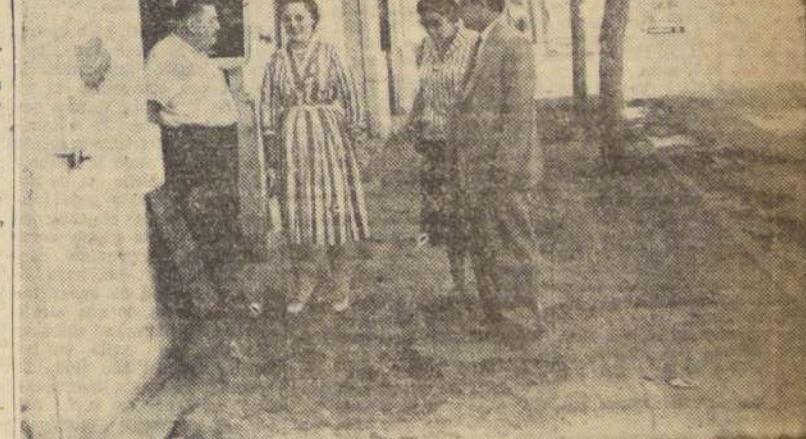
ARREGLAN ACERAS. — A petición de numerosos vecinos de la comuna de La Cisterna, la regidora Raquel Lazo de Cappi, solicitó la visita del Inspector Zonal de Pavimentación Urbana, Ingeniero Juan Parada, para comprobar el mal estado en que se encuentran las aceras de la Gran Avenida, de ese sector, entre los paraderos 17 y 30. Después de esta visita y por instrucciones de la Dirección General, el jefe comunal de Pavimentación, Archibaldo Villalobos, dispuso la inmediata iniciación de los trabajos de reparación. En el grabado, la regidora Raquel Lazo y el Ingeniero Parada, observan los deterioros de las aceras, junto con vecinos de La Cisterna.
