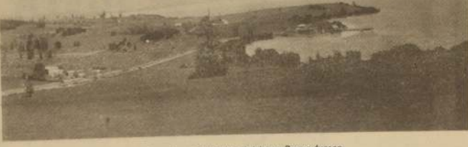
Las obras de construcción del Lago Ranco fueron recomenzadas recientemente con mayores recursos.
