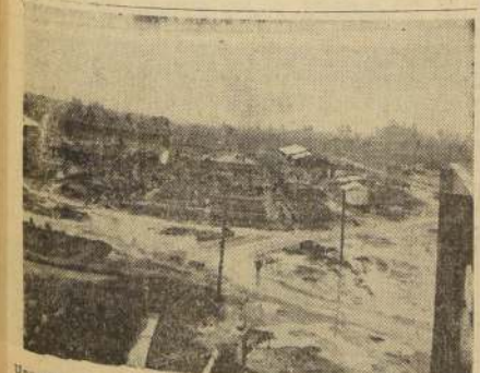
Una vista aérea de la Planta en construcción en Llanquihue. Será la tercera y con la cual IANSA estará en condiciones de abastecer normalmente, el mercado interno.
