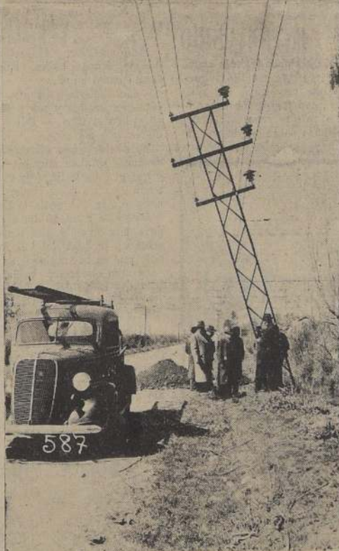
La torre 234, ubicada en el interior de un potrero cerca de Malloco, en cuya base los nacistas hicieron explotar los cables conductores de electricidad. Ha sido necesario excavar el terreno para reponerla
