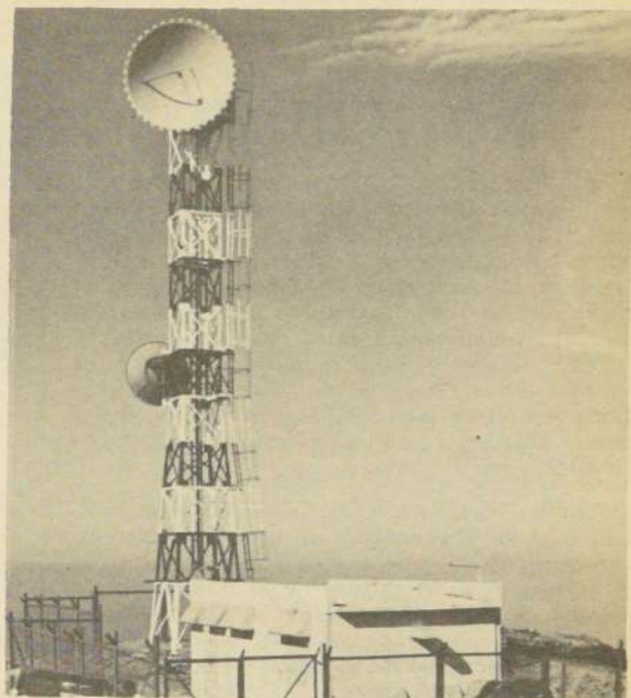
Repetidor de microondas de la red troncal norte, de ENTEL. La necesidad de conexiones es más imperiosa para las zonas extremas del país.
