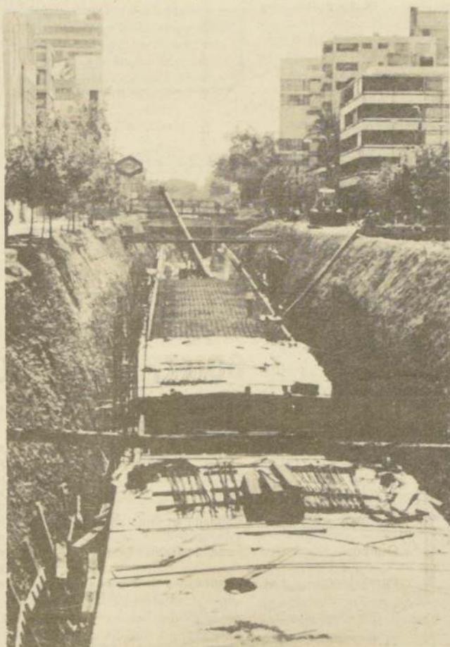
En plena avenida Providencia las faenas del Metro entrarán en la fase del relleno del túnel y el término de las estaciones, habiéndose cumplido así con los plazos fijados.
