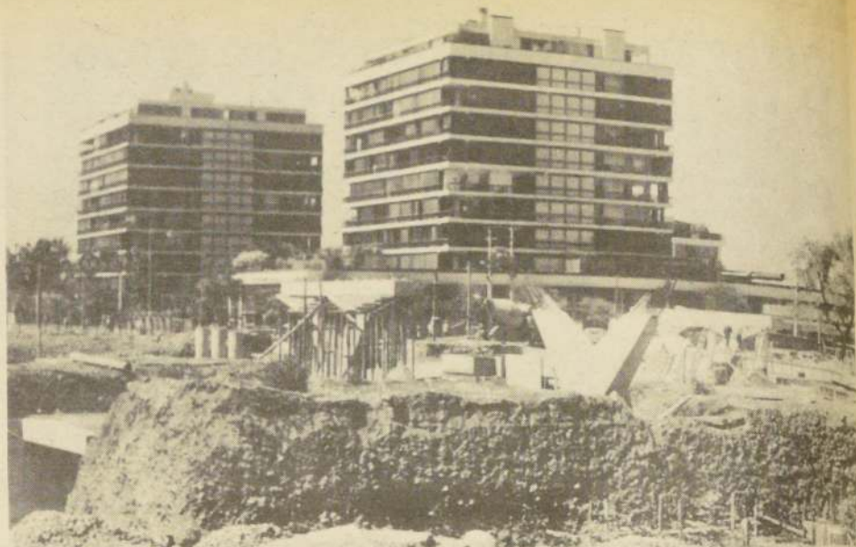
Un aspecto de los avances logrados en el sector de Escuela Militar. Para ir más rápido, el túnel se ha cavado con dos escuadrillas que partieron en los puntos oriente y poniente hasta juntarse.
