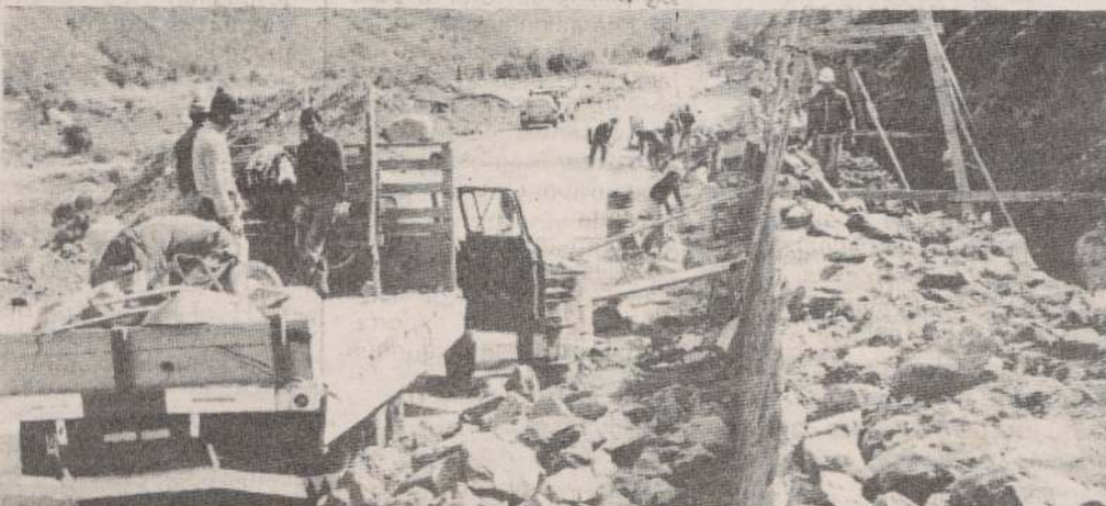
Obras Públicas aborda también la dotación de defensas y reparaciones del pavimento en la Ruta Internacional Carretera San Martín de Los Andes a Mendoza.
