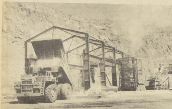
Camiones de 100, 120 y próximamente de 180 toneladas emplea Cobre Chuqui para el movimiento de minerales desde su mina hasta el molino primario, instalado en el interior de la mina. En el grabado un camión de 100 toneladas en plena faena.
