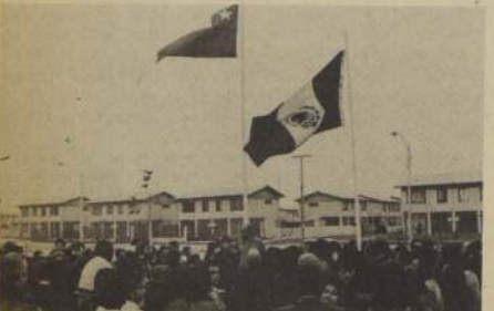
Funcionarios del Ministerio de la Vivienda y Urbanismo construyeron una Plaza de Juegos Infantiles en el Día del Trabajo Voluntario. EN LA FOTO, el Ministro Cantuarias inaugura las instalaciones para esparcimiento de los niños, en la Villa México.
