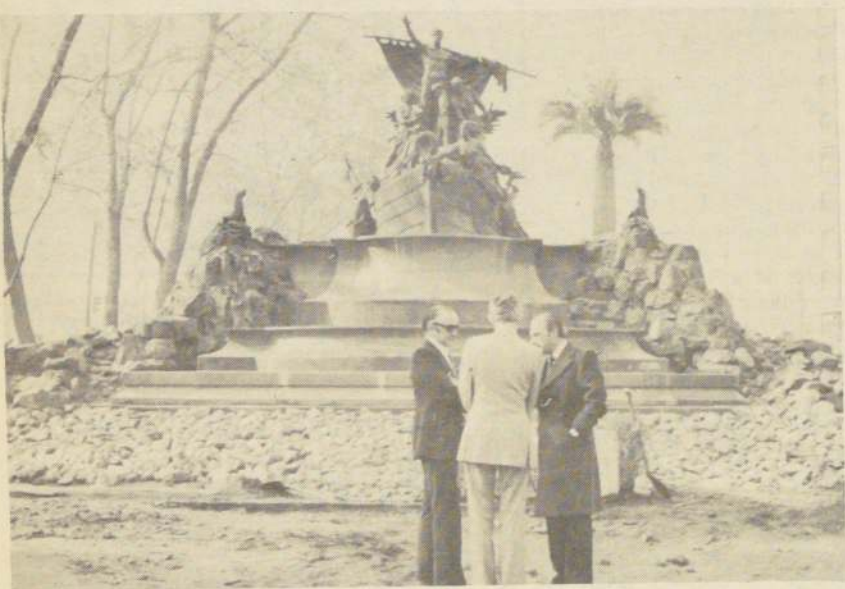
REMEDIACION DE "FUENTE ALEMANA".— En forma acelerada se trabaja en la remodelación de la "Fuente Alemana", labor que culminará a fines de mes, según lo informó ayer, luego de una visita al lugar, el Alcalde de Santiago, Patricio Guzmán. La restauración forma parte del trabajo de recuperación del Parque Forestal, en cuyo extremo Este se levanta la fuente, y consiste en hermoseamiento de su entorno, nueva iluminación e instalación de una cañería que lanzará agua contra la proa del navío.
