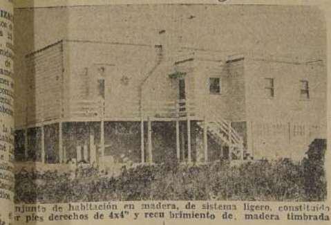
Un tipo de habitación en madera, de sistema ligero, constituido por pilas de madera de 4x4 y recubrimiento de madera laminada.
