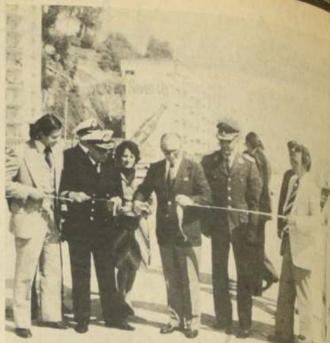
La continuación de las obras de ensanche de la Avenida España permitirá habilitar y entregar una nueva playa a la ciudad de Valparaíso en el sector de Caleta Portales. La foto de arriba muestra la ceremonia de entrega de una etapa de dicha obra.
