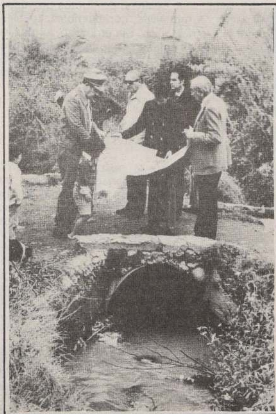
Permanentes actividades en terreno efectúa la autoridad comunal. En la fotografía, por ejemplo, se le observa analizar los planos de la construcción del canal que recibe las aguas que llegan de las comunas del sector alto.
