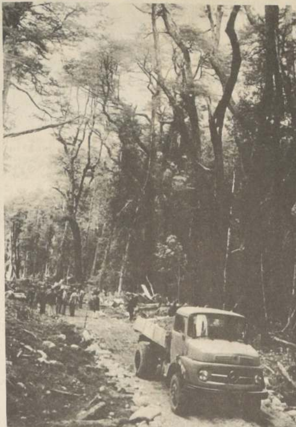
El Ministro de Obras Públicas y el director de Vialidad inspeccionan en estos días el avance de los trabajos en el sector.
