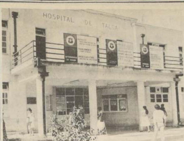
Frontis del Hospital Regional de Talca, donde se ejecutan reparaciones mayores en el edificio, con recursos especiales por un monto de 1 millón de dólares que aprobó el Presidente de la República.
