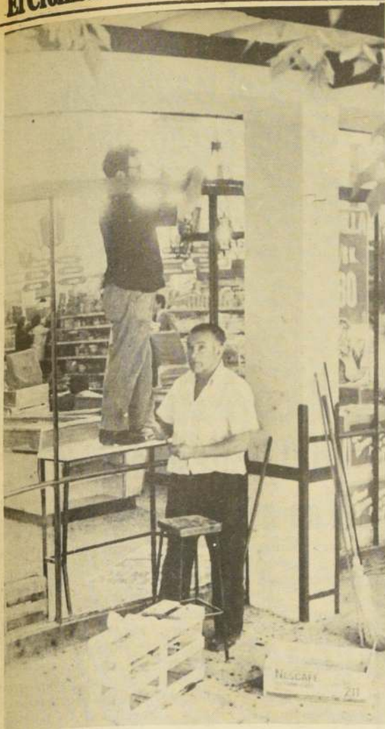
BOMBA EN ALMAC. — Funcionarios de Almac reponen un vidrio quebrado en el establecimiento de Américo Vespucio 1796, en donde estalló una bomba que causó daños menores. En un documento clandestino, el MIR se atribuyó todos los últimos atentados dinamiteros que han ocurrido en el país, como parte de un plan destinado a crear conflictos artificiales a las autoridades.
