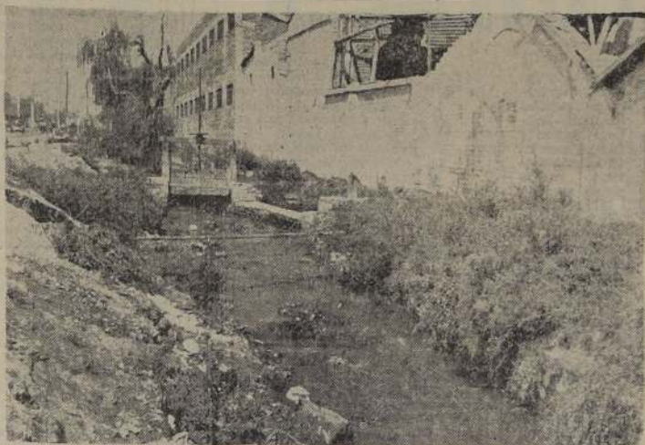
FOGO DE INFECCION Y DE PELIGRO. — Esta es la realidad del canal que corre junto al camino de Santa Rosa, que cuenta con una creciente población especialmente obrera. LA NACION pudo comprobar en una rápida visita, la urgente necesidad de un novedadismo para eliminar una potencial causa de epidemias.
