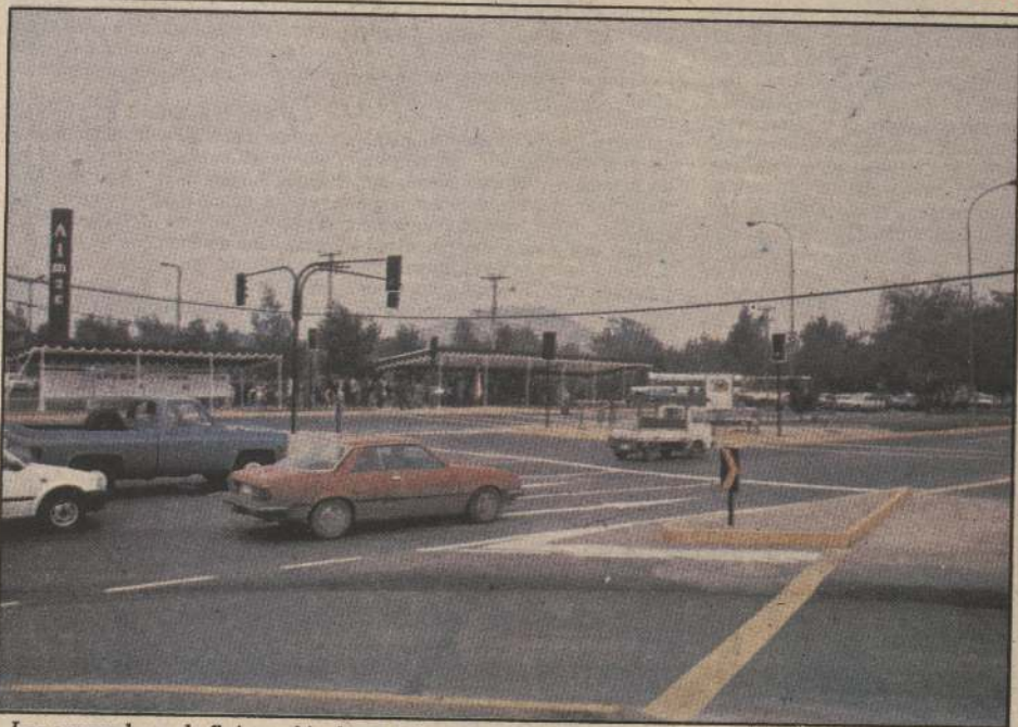
Los separadores de flujos vehiculares, seis en la comuna de Las Condes, conforman una de las primeras medidas para mejorar la calidad del aire en la capital. Estos bandejones evitan los atochamientos y disminuyen la contaminación en el Gran Santiago.
