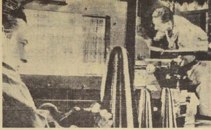
NUOVA YORK.— En esta foto que acaba de darse a conocer, pueden verse dos científicos usando los probadores ultrasónicos en el cono o nariz del satélite "Explorador". El vibrador se usa para hacer las pruebas finales del espesor de las paredes del cono. Un rayo de luz en el tablero indica el grosor gráficamente. Conos parecidos serán usados en el próximo satélite del Ejército. (Radiofoto UNITED PRESS).
