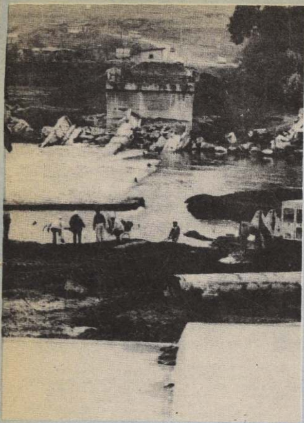
Una vista del puente Lo Gallardo sobre el río Maipo en San Antonio en uno de los tramos que se derrumbó como consecuencia del sismo del domingo 3 de marzo. Los trabajos de reparación y reforzamiento estarán terminados a fines del presente año, según se dio a conocer en el puerto. En el intertanto, continuará funcionando el puente de mecano que instaló la Escuela de Ingenieros Militares de Tejas Verdes.
