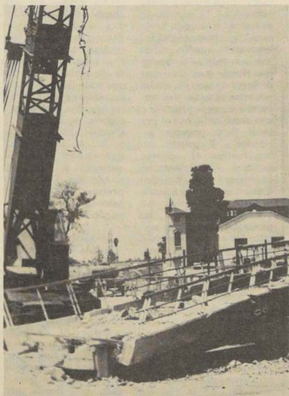
Un puente peatonal se derrumbó, al mediodía de ayer, cuando el alambre que lo sostenía cedió, enviándolo a tierra. El hecho ocurrió en la Panamericana Sur, cuando se procedía al traslado de dicho puente, por los trabajos de la línea N° 2 del Metro de Santiago. En el accidente no se registraron desgracias personales.
