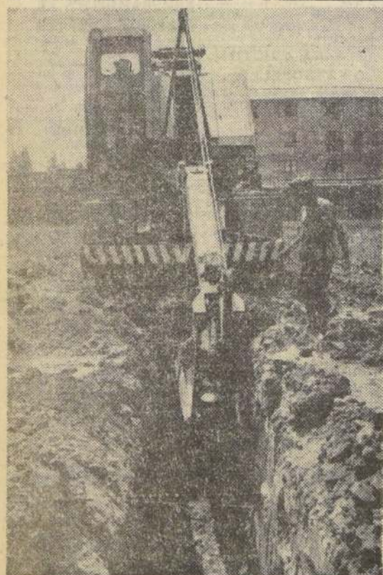
LOS CIMENTOS. — Con modernas palas mecánicas se abren los cimientos para mil cien nuevos departamentos de la Población "Juan Antonio Ríos".
