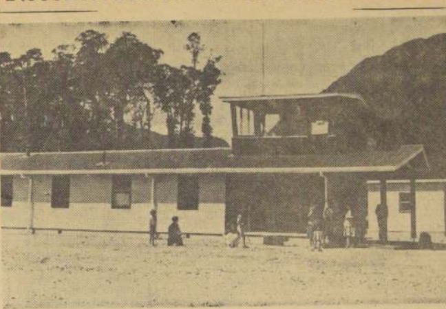
EL EDIFICIO DEL AEROPUERTO DE CHAITÉN con su torre de control, ubicado en la provincia de Chiloé, es otra de las realizaciones del Ministerio de Obras Públicas en su plan de reconstrucción. El antiguo edificio fue totalmente destruido por los sismos de mayo de 1960.
