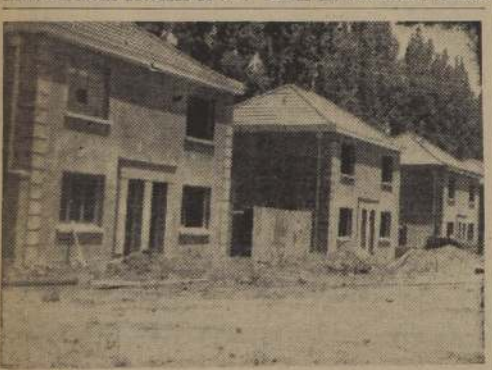
POBLACION CHACABUCO, AMPLIACION. — El grabado muestra un aspecto de las nuevas casas de esa población que, en breve, serán entregadas a los imponentes.
