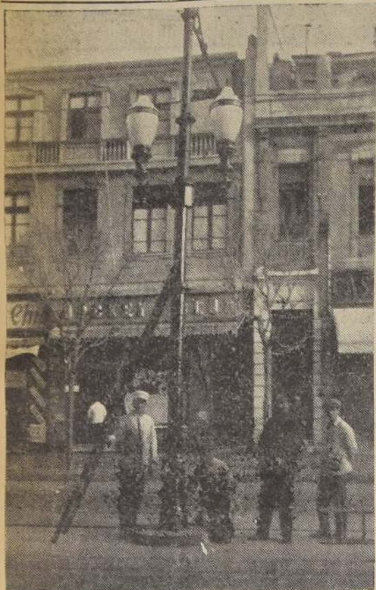
Modelo del nuevo alumbrado que se proyecta para la Avenida Pedro Montt, aprovechándose los mismos postes del trolley de los tranvías y a una altura mucho más baja y conveniente que en la actualidad. Además puede verse la presentación del foco que es mucho más elegante que los actualmente en uso.
